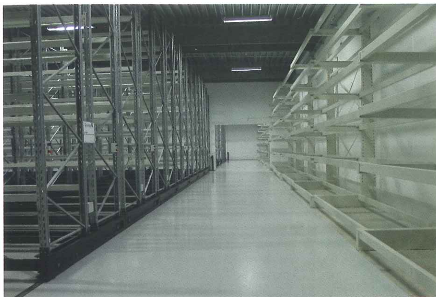
Kompaktpallereoler i 2 af de nye haller i Fællesmuseumsmagasiner. Reolerne er motordrevne og kan bevæges frem og tilbage på skinner der er nedlagt i gulvet. Når reolerne står stille, frakobles strømmen for at minimere brandfaren og nedsætte strømforbruget. Foto: Lise Ræder Knudsen.
